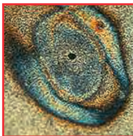
Ejemplo de corrosión de picadura
