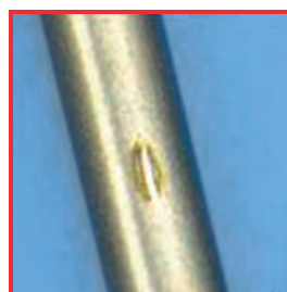
Corrosión de contacto: Acero inoxidable/Acero inoxidable
